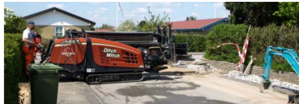
Boremaskinen hvormed der bores fra vejen ind under haven til bryggeret.
