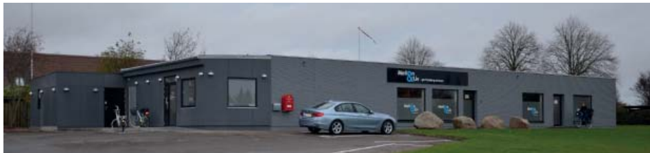
Orholt Allé 10 - efter ombygning
